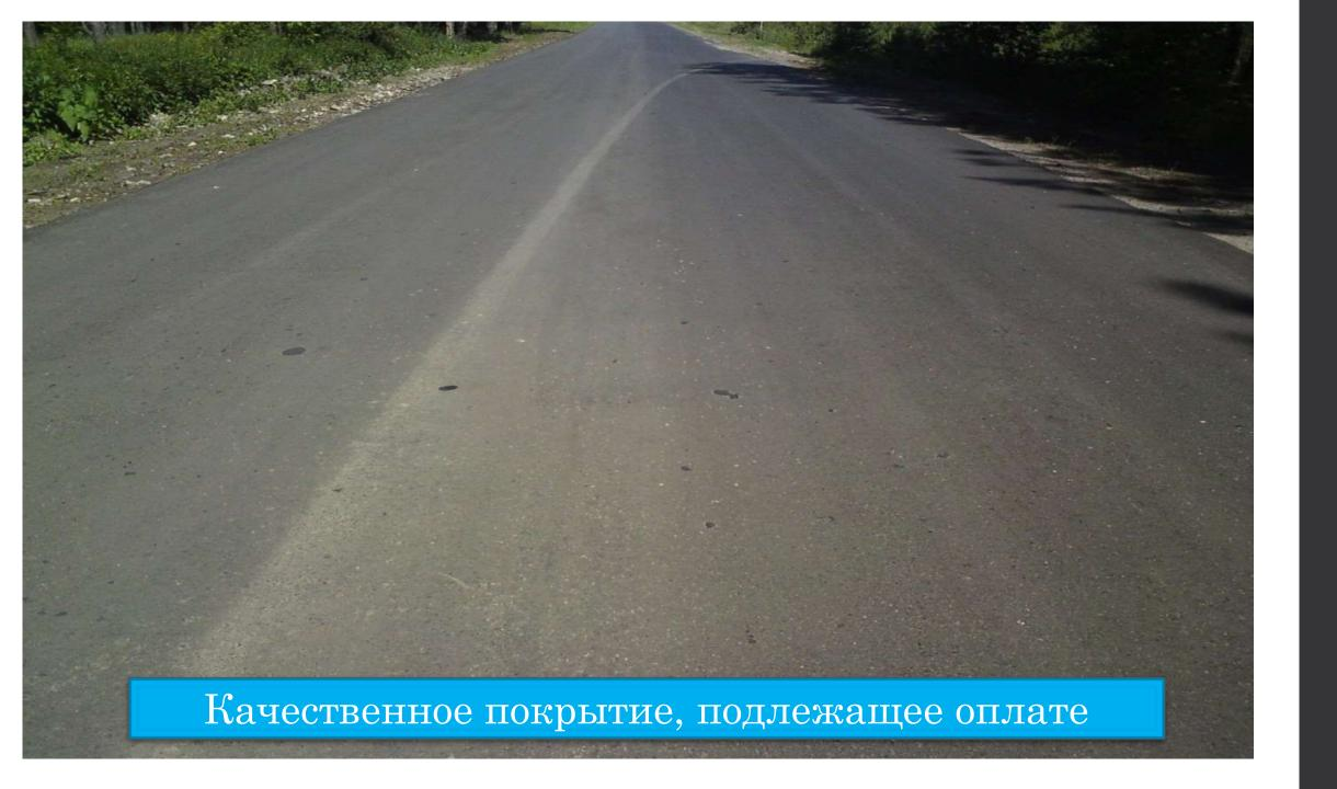
Имеются места сегрегации (неуплотнённые, расслоения а/б смеси), Имеется холодный продольный шов Нарушены требования СП 78.13330.2012 СНиП 3.06.03-85 п.10.29, п.10.31
