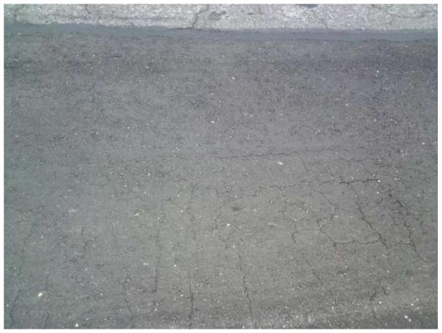
Сетка трещин - необходимо переделать Нарушены требования СНиП 3.06.03-85 п.10.31, п.10.23
