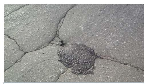
Асфальт уложен на неотфрезерованный участок. Кромка ремонта не обработана битумным вяжущим Нарушены требования технологической карты "Ямочный ремонт горячим способом"
